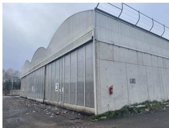
Zdjęcie 6. Hala kompostowni (B2)
