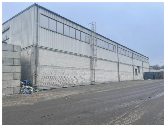
Zdjęcie 4. Hala sortowania odpadów (B1)
