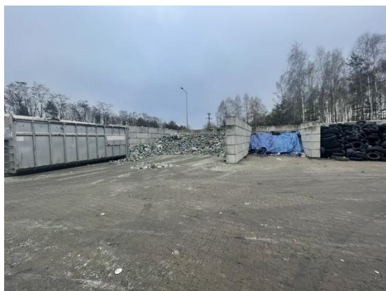
Zdjęcie 1. Strefy pożarowe - magazyn odpadów (M4)
