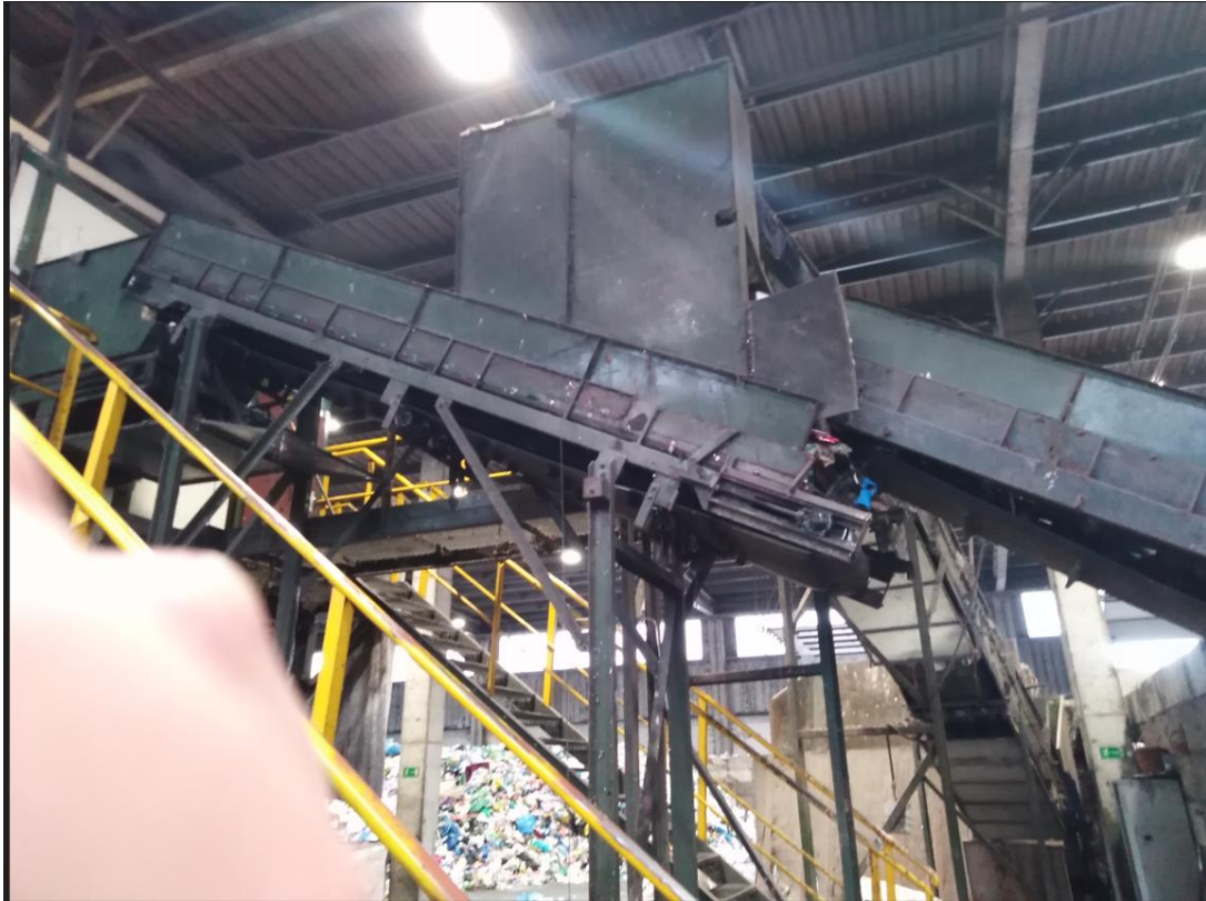
Wnętrze sortowni odpadów
