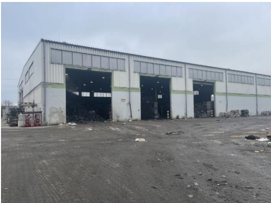
Zdjęcie 3. Hala sortowania odpadów (B1)
