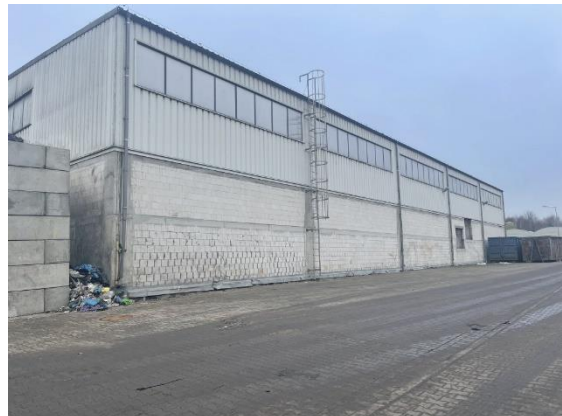
Zdjęcie 4. Hala sortowania odpadów (B1)
