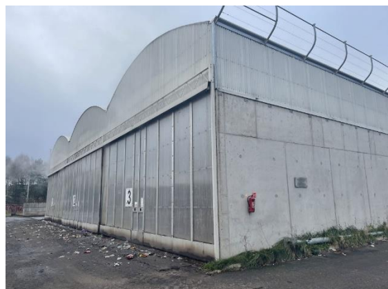
Zdjęcie 6. Hala kompostowni (B2)
