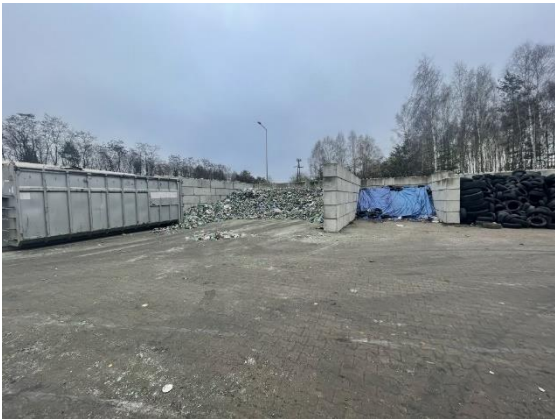
Zdjęcie 1. Strefy pożarowe - magazyn odpadów (M4)
